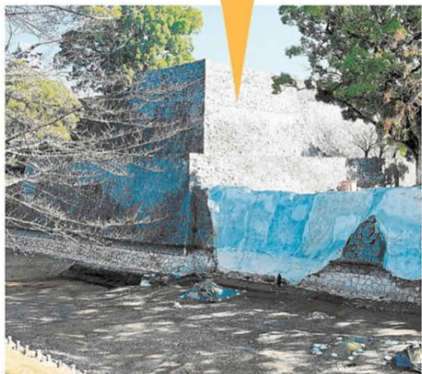
飯田丸五階櫓の石垣。南面に設置された受圧板に日光が当たると輝いて見える＝13日午前10時ごろ、熊本市中央区
